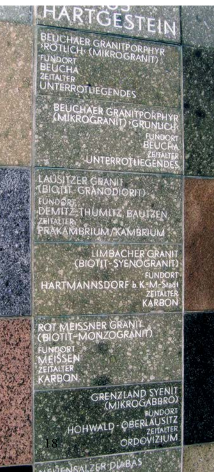
Betonsäulen am Kirchbruch Beucha, ummantelt mit Werksteinen aus sächsischen Gesteinsvorkommen
