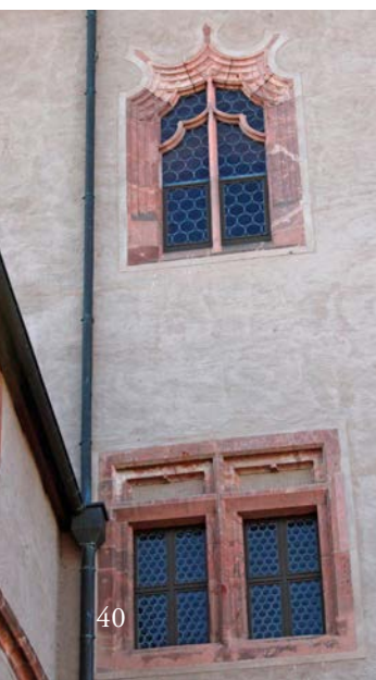
Vorhangbogenfenster am Querhaus des Schlosses Rochlitz
